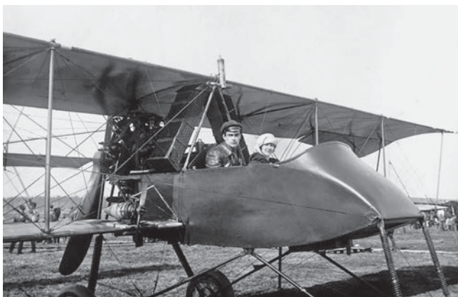
▶ Самолет «Вуазен» был создан по схеме биплана с толкающим винтом.
